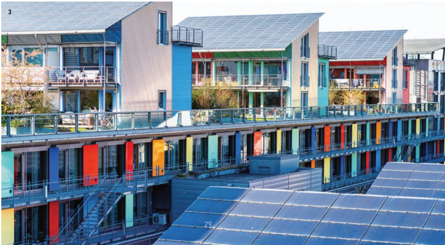
3. 프라이부르크의 그린 시티(Green City)에 설치된 태양광 지붕
