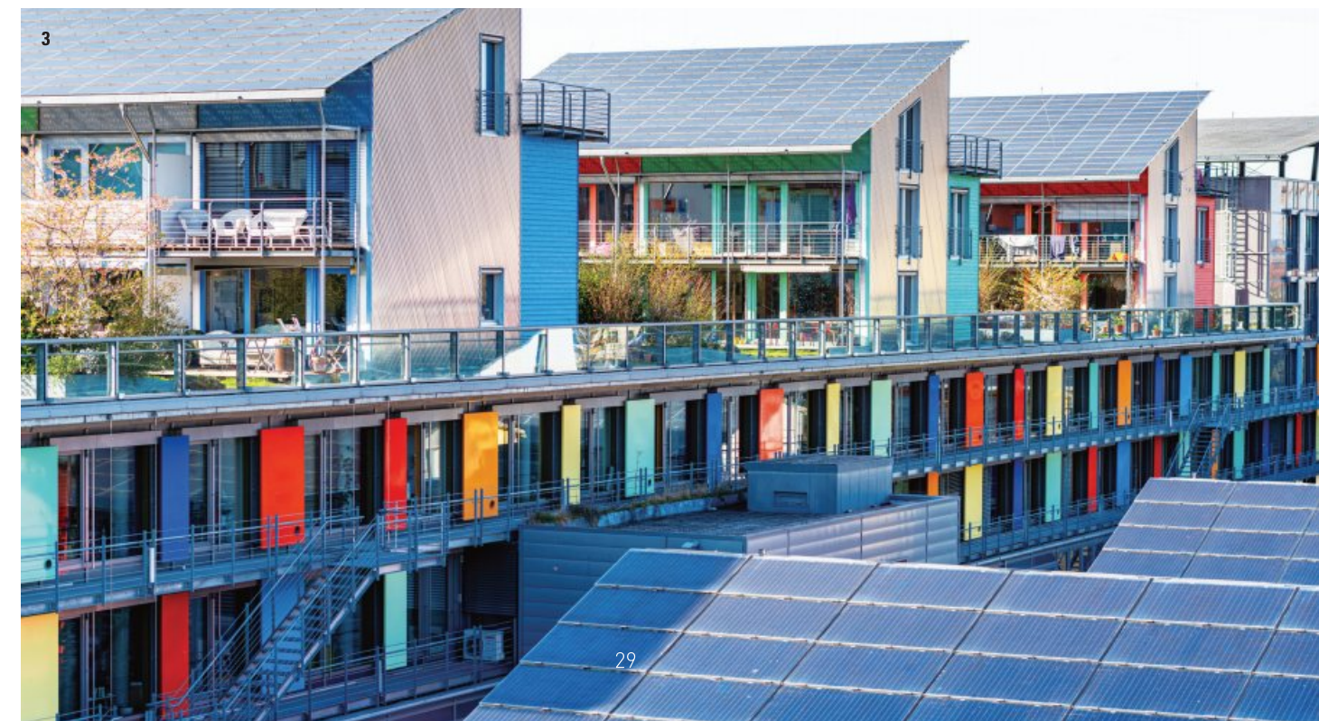
3. 프라이부르크의 그린 시티(Green City)에 설치된 태양광 지붕
