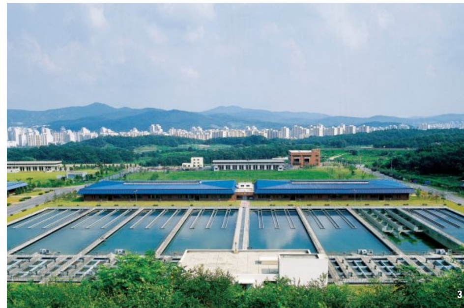
3. 성남정수장 전경 4. 성남 광역정수장 수소생산 활용 및 부가가치 개발 실증플랜트 연구 5. 그린수소 연계 충전 인프라 구축 및 무공해 버스 전환을 위한 업무협약
