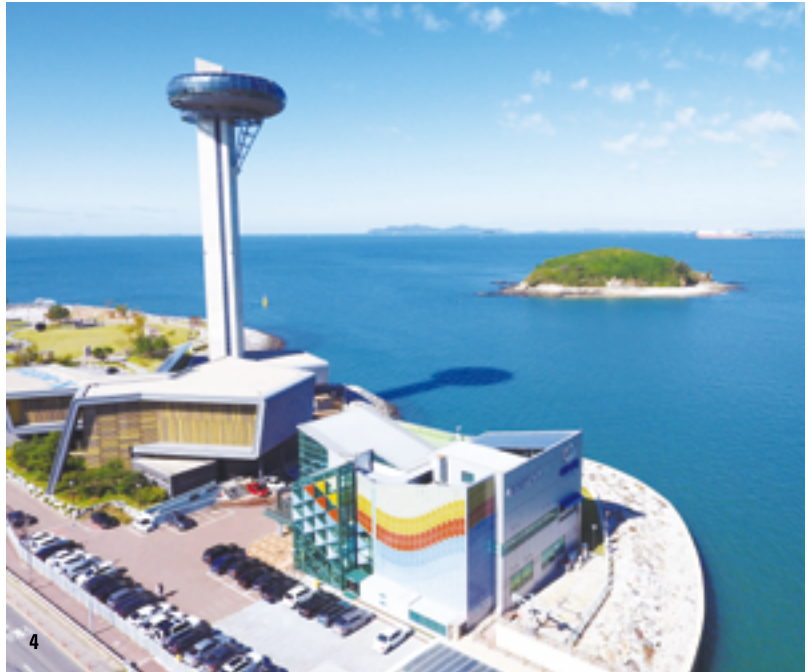
2. 시화호 조력발전소 수문 3. 수차발전기 4. 시화호 조력발전소 관리동 BIPV
