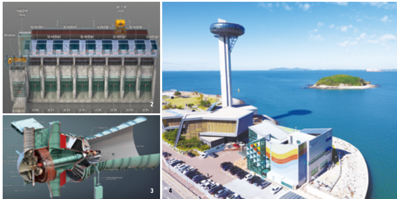
2. 시화호 조력발전소 수문 3. 수차발전기 4. 시화호 조력발전소 관리동 BIPV
