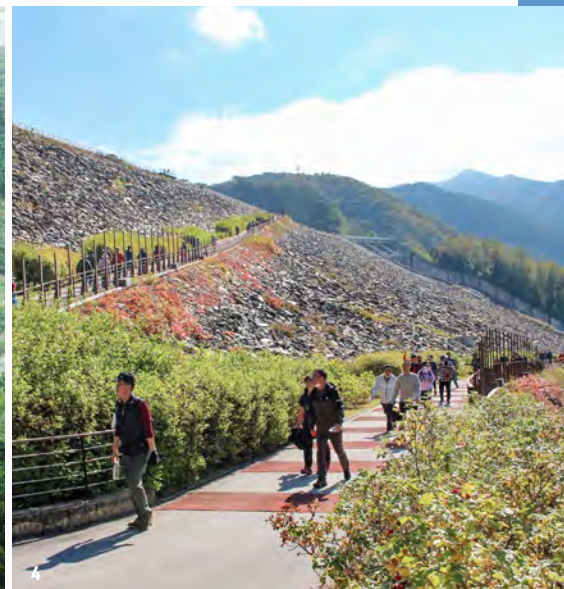
3. 소양강댐 종합 리노베이션 전경 조감도 4. 소양강댐 용너미길
