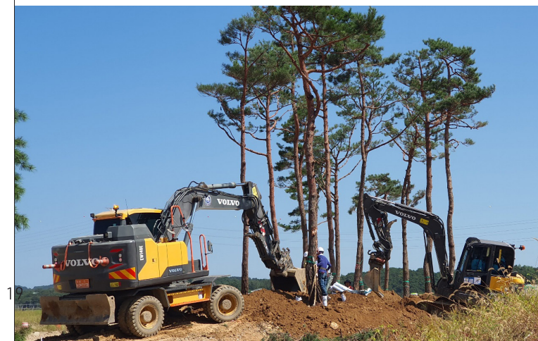
강동완 씨가 직접 찍은 송산그린시티 조경공사 현장.
